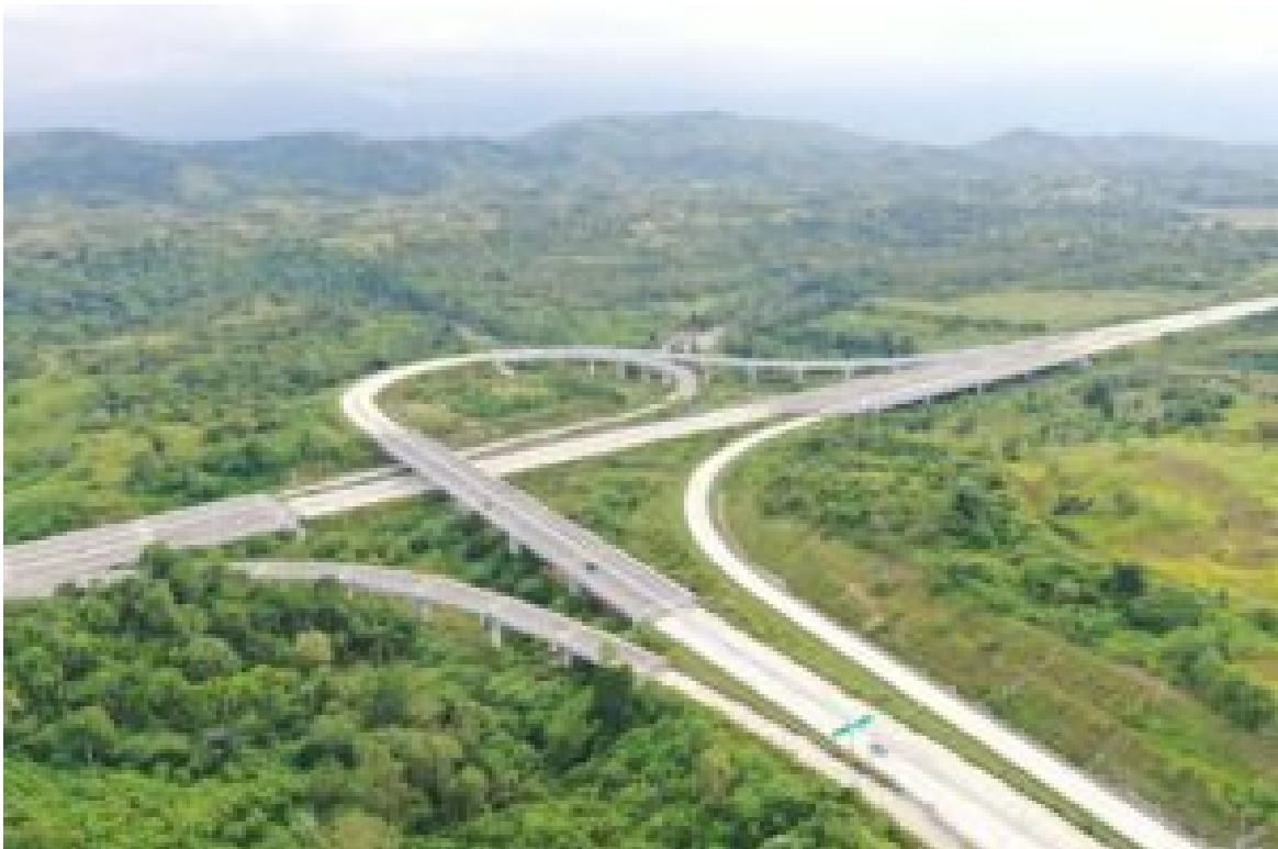
Jalan Tol Sigli – Banda Aceh. |FOTO: Dok. Ist
